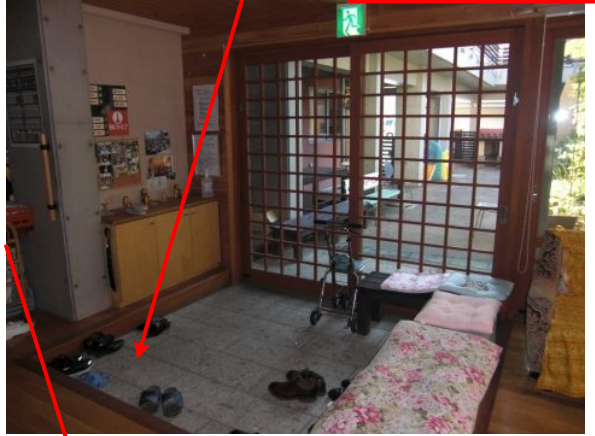
靴を履き替えるのに意図的に段差(上がり框)を設けている。部屋こ上がる意識を認識させる。過剰なバリアフリーは入居者の意識、運動能力を低下させること、外出先ではバリアフリーでないので対応が難しくなるとのこと。
