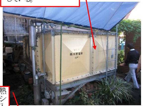
建物の雨水を集めてタンクに貯水し池の水を循環している。
