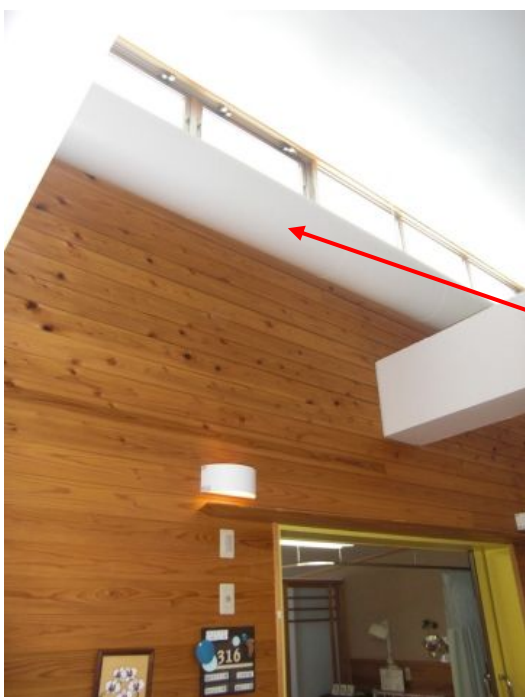
病棟天井下のダクト。太陽熱集熱パネルで暖められた空気がダクトを通して1階床下のコンクリート蓄熱層へ送られる。
