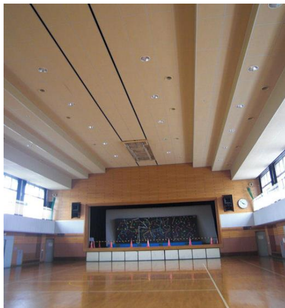
(体育館) 天井は音響を考慮し階段状、壁の上部も吸音仕様となっている
